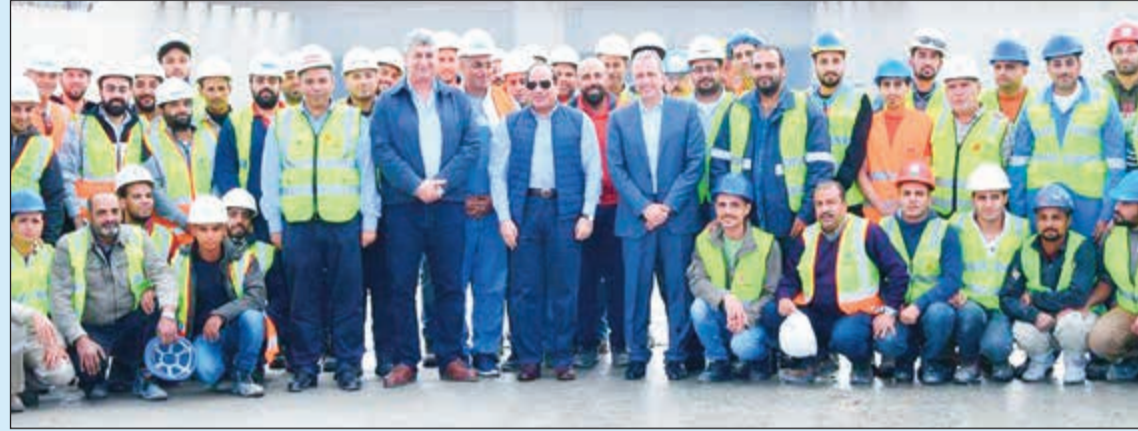
الرئيس عبدالفتاح السيسي يتفقد تطورات الأعمال في مشروع أنفاق قناة السويس شمال الإسماعيلية والمراحل الإنشائية بالعاصمة الإدارية الجديدة
