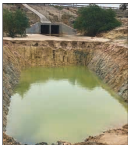
خزانات أرضية لتخزين مياه الأمطار
