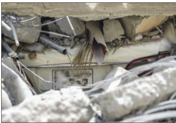
أحدى المركبات وقد غطتها الكتل الخرسانية
