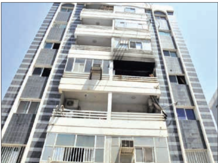
البنية التي اندلع الحريق في إحدى شققها
