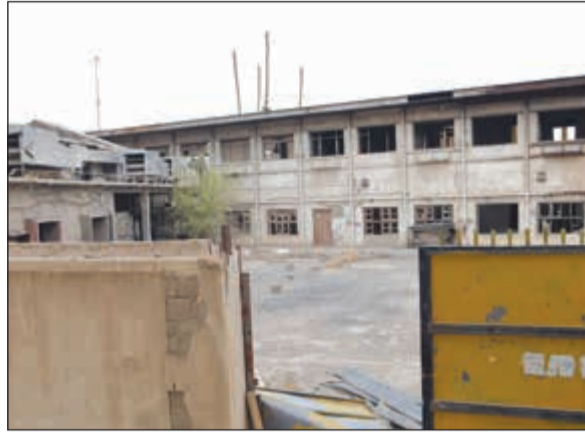
المبنى من الخارج
