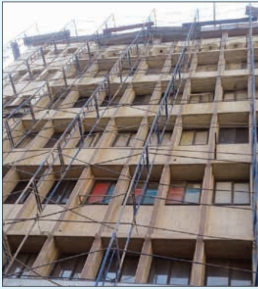
أحد المباني القديمة يخضع للترميم تجاوبا مع القرار
