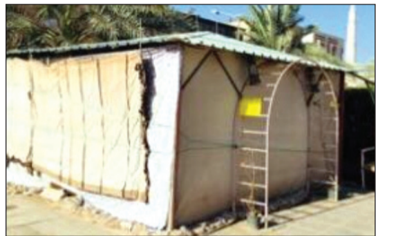
إحدى المنشآت المخالفة
