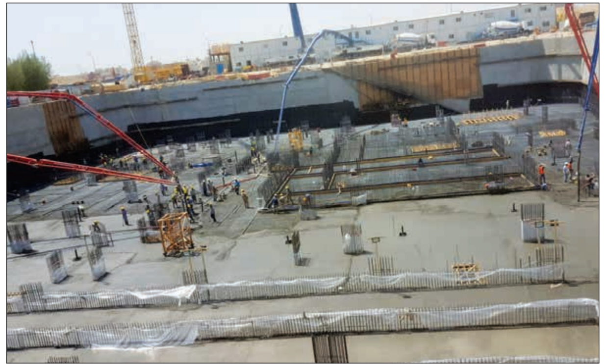
أكثر من 620 خلاطة وأكثر من 100 مضخة أسمنت ساهمت في عملية صب أساسات المشروع وفق نظام Design-Build
