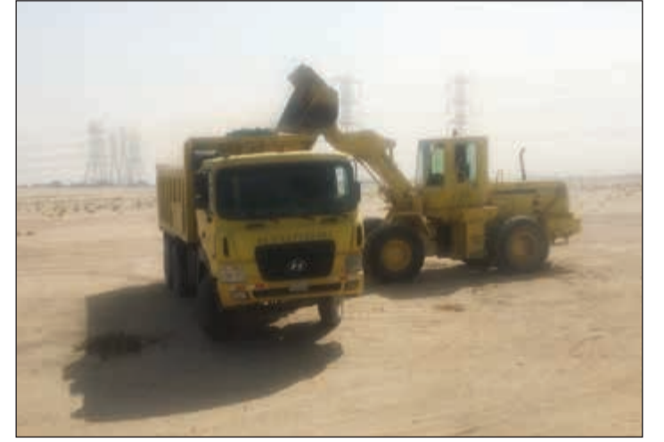
نقل الرمال لموقع الحريق
