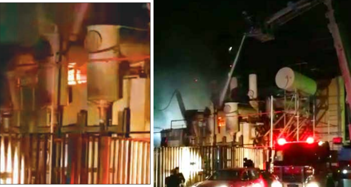
الحريق تجدد في محطة الزور.. والتحقيق مازال جارياً
