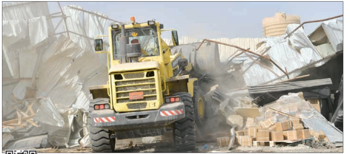
إحدى آليات البلدية خلال إزالة إحدى «الحوط» في منطقة جنوب خيطان
