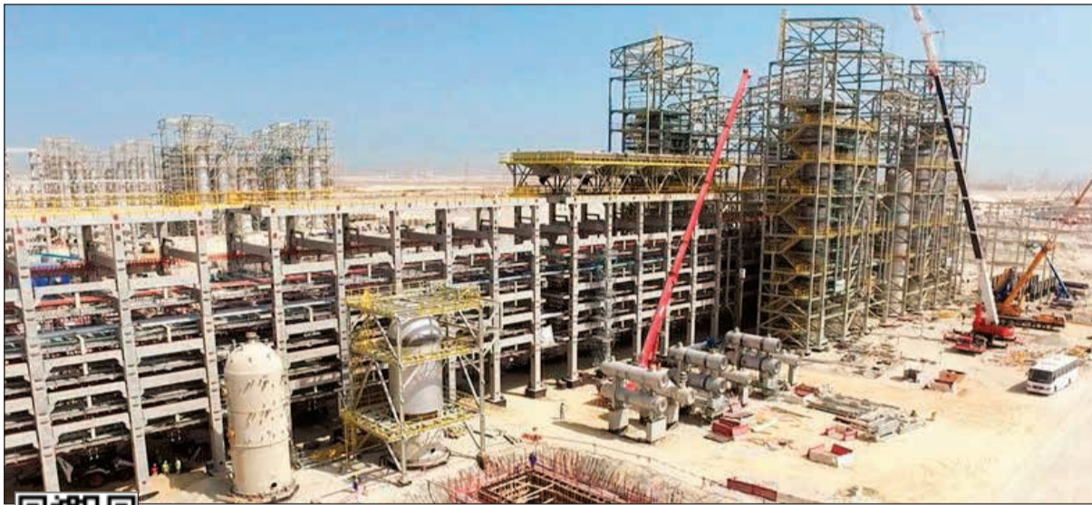
صورة تظهر آخر تطورات الاعمال في مشروع مصفاة الزور
