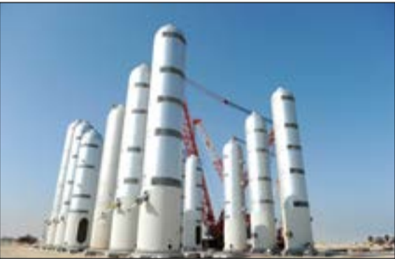
جانب من أعمال التشييد في مصفاة الزور جنوب البلاد
