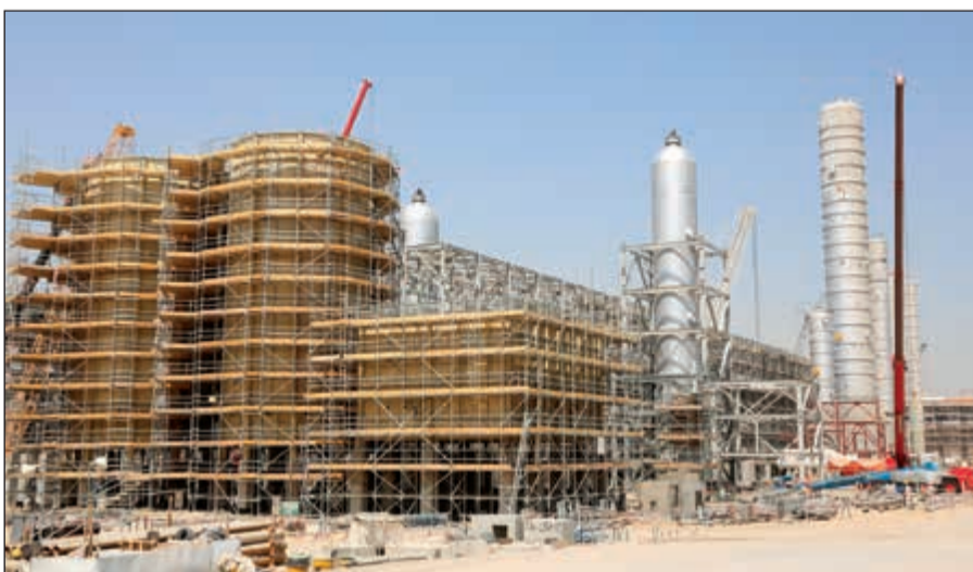
لقطة توضح حجم الإنشاءات في مشاريع منطقة الزور الجنوبية
