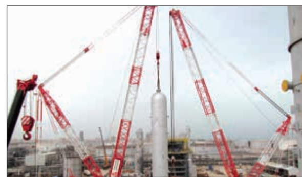
جانب من عمليات تركيب أبراج التطهير في مشروع الوقود البيئي
