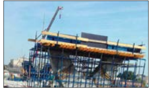
جانب من أعمال صب الأعمدة
