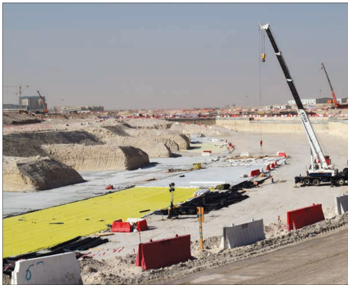
من أعمال التجهيزات الخرسانية للقواعد
