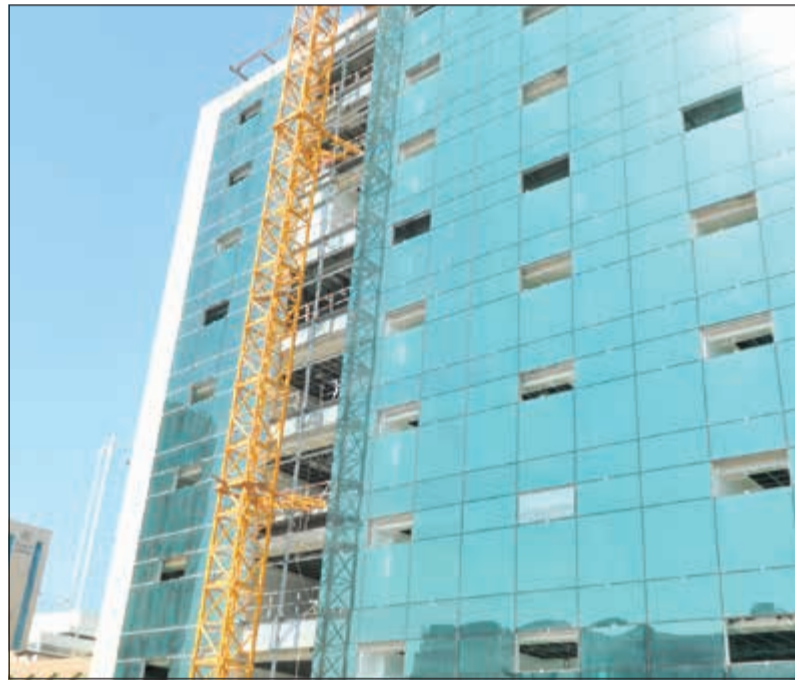
واجهة المبنى من الزجاج المقاوم للحرارة
