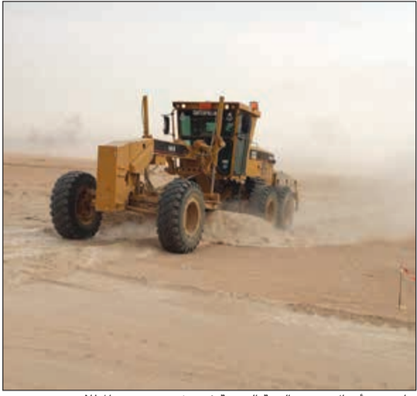
جانب من أعمال تجهيز البنية التحتية في مشروع جنوب المطلاع
