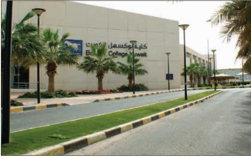
مبنى كلية بوكسهل
