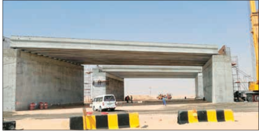
جانب من أعمال الإنشاءات في أحد الطرق
