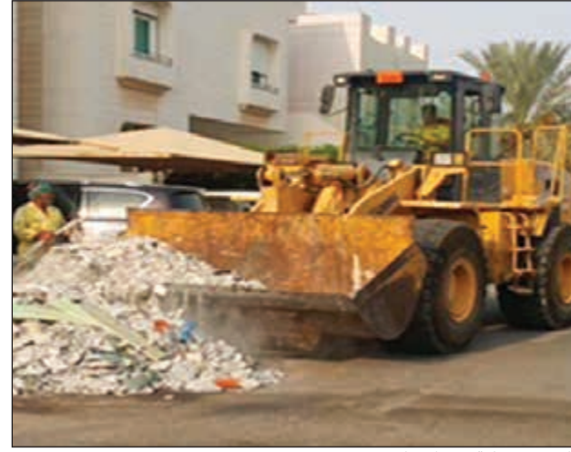
جانب من عملية رفع الأنقاض
