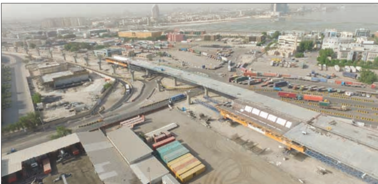
أعمال العوارض الصندوقية المصبوبة بالموقع بنظام الشدات المنزلفة - جسر ميناء الشويخ
