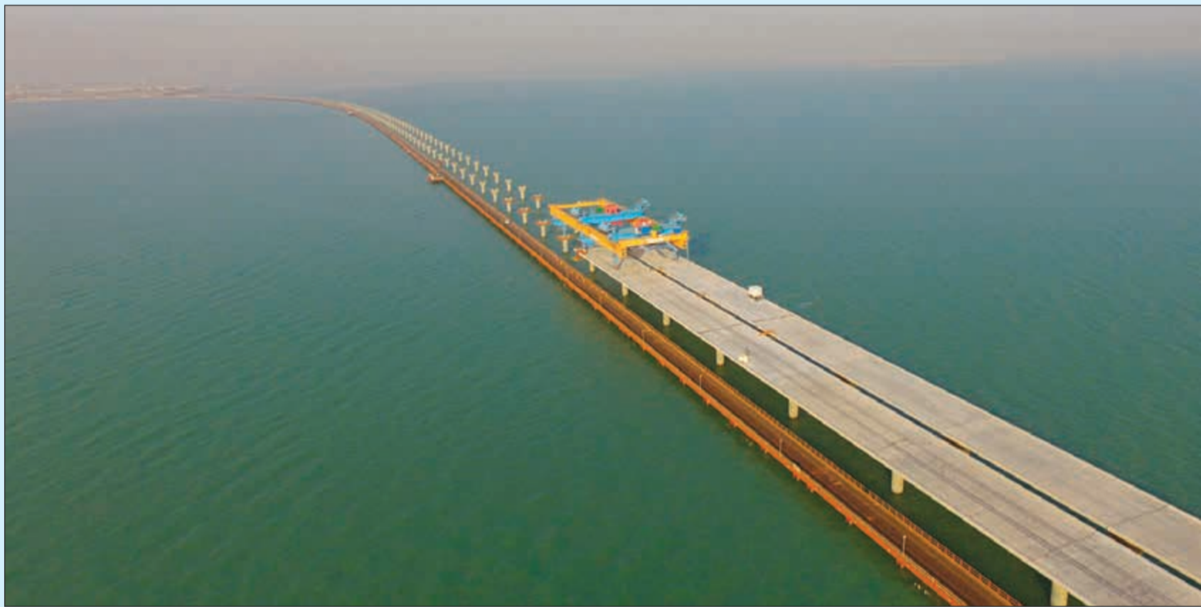
أعمال تركيب العوارض الصدوقية سابقة الصب ضمن مشروع جسر الشيخ جابر
