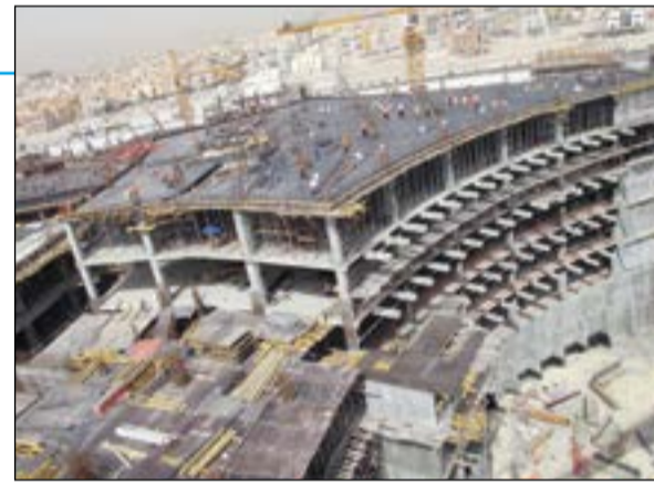
جانب من اعمال البناء والإنشاء في مستشفى جابر
