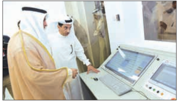
الوزير يتفقد احد أنظمة التحكم في المبنى الجديد
