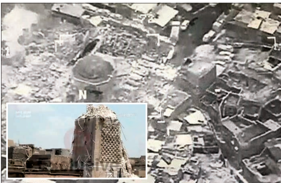
صورة جوية وزعتها قوات التحالف للمسجد النوري الكبير في الموصل بعد تدميره وفي الاطار صورة لقاعدة المنارة الحدياء بعد تدميرها ايضاً
