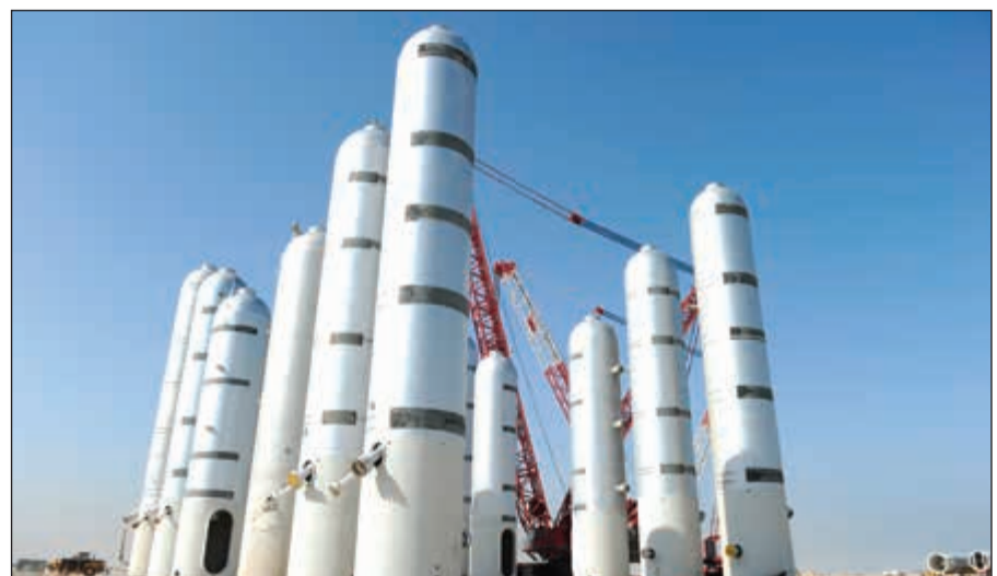
جانب من تركيب مفاعلات مصفاة الزور
