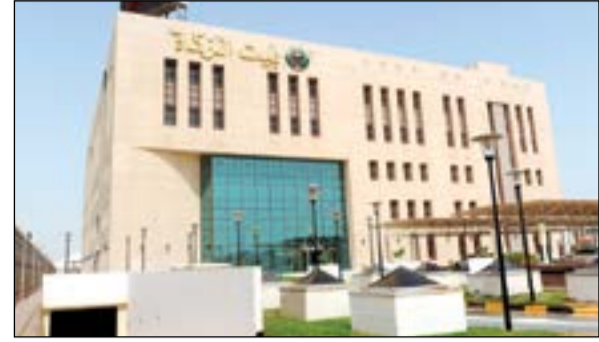
مبنى بيت الزكاة
