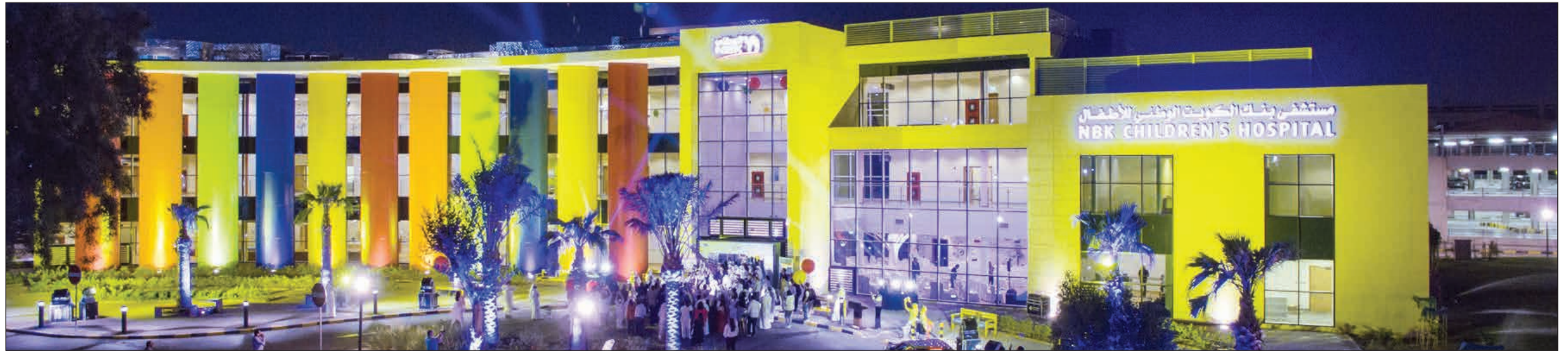
مبنى مستشفى البنك الوطني التخصصي لعلاج الأطفال في منطقة الصباح الطبية
