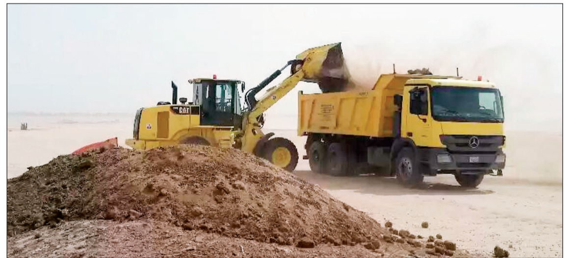
نقل المخلفات وانقاض البناء
