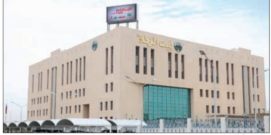
مبنى بيت الزكاة
