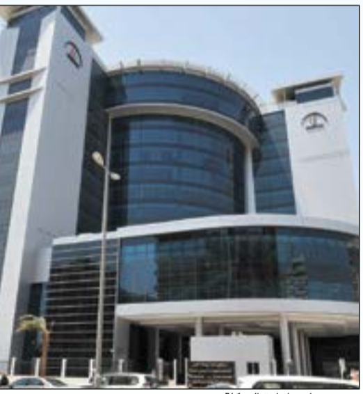
مبنى برنامج إعادة الهيكلة
