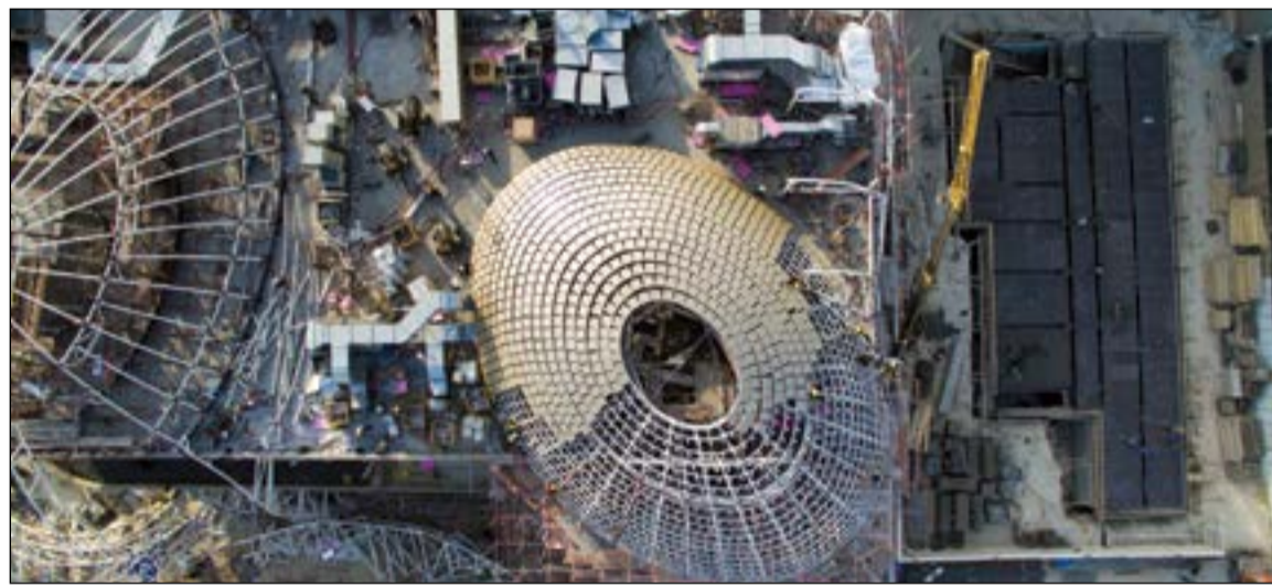
عمليات بناء مبنى السينما المرحلة الرابعة، الأقنيوز الكويت
