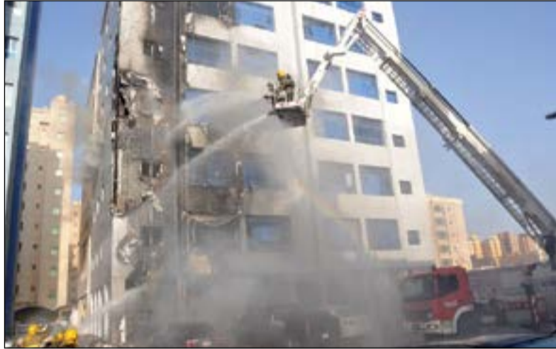
عمليات اطفاء الحريق في بنائية المهولة
