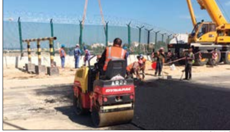
آليات «الأشغال» تعيد رصف الطريق
