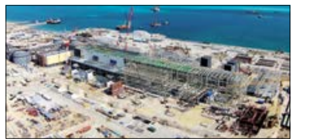
جانب من أعمال التشييد والبناء في محطة الزور الشمالية
