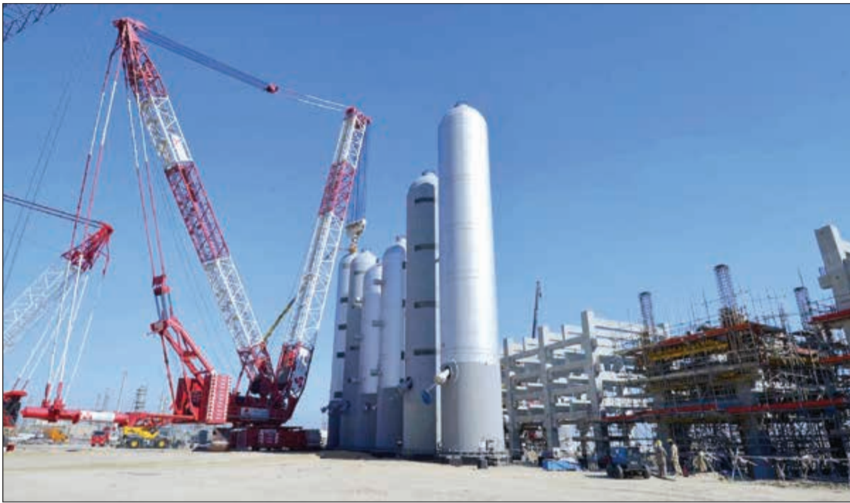
صورة توضح مراحل إنجاز مشروع الوقود البيئي حالياً
