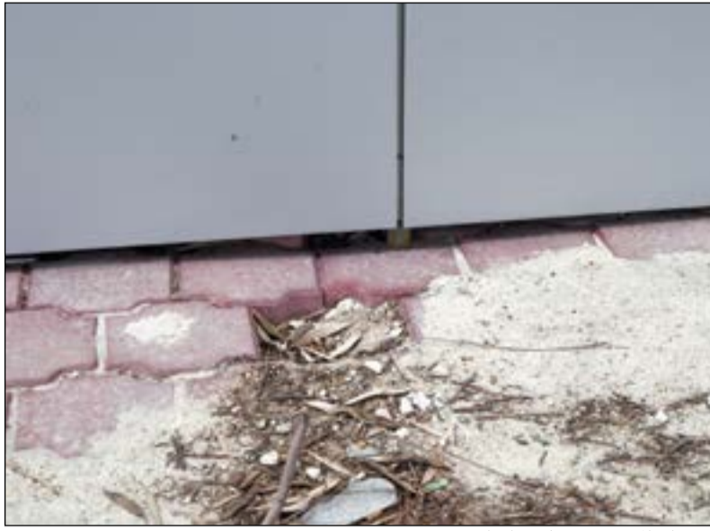
تجهيزات المبنى لا ترقى لعمل الإدارة
