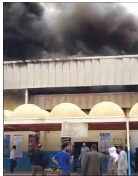
الحريق خلف سحبا دخانية كثيفة
