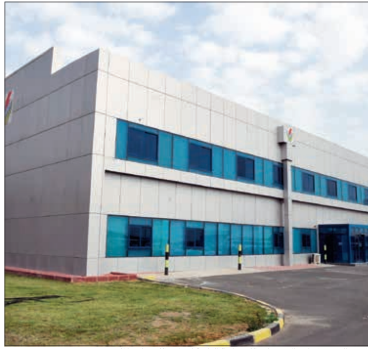
المبنى الجديد لإدارة التمديدات الكهربائية التابعة لوزارة الكهرباء والماء
