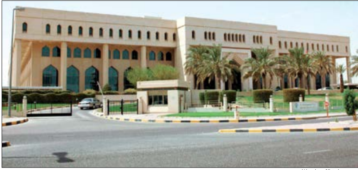
مبنى وزارة الكهرباء والماء
