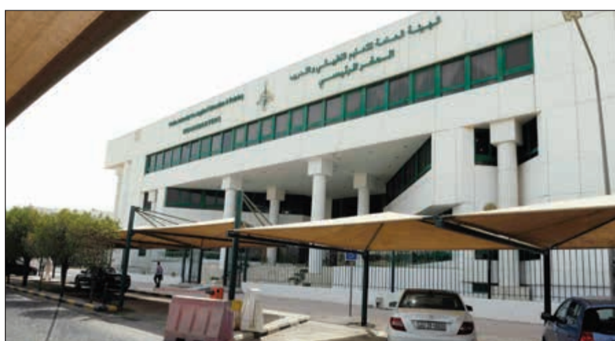
مبنى الهيئة العامة للتعليم التطبيقي والتدريب
