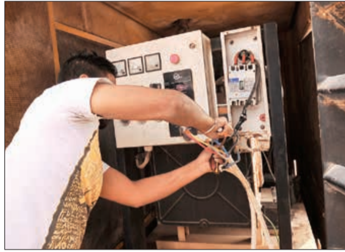
فصل التيار عن محول كهربائي
