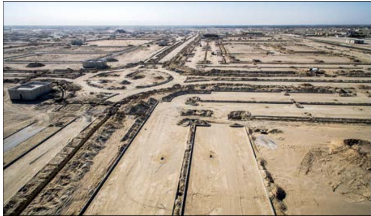
جانب من أعمال البنية التحتية للمشروع
