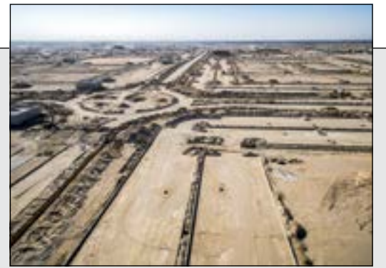
جانب من أعمال البنية التحتية للمشروع
