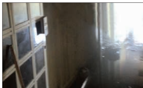
جانب من الحريق بسبب ماس كهربائي
