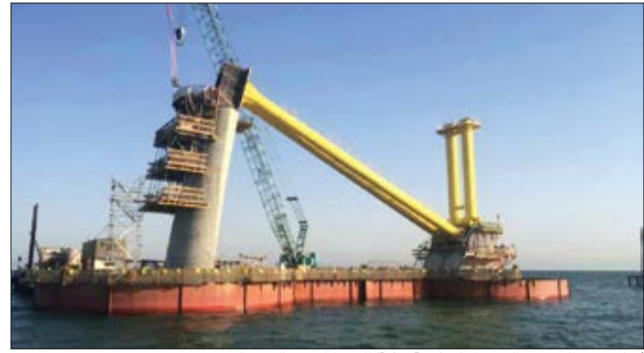
أعمال تنفيذ قاعدة برج الجسر المعلق (Pylon Base) للممر الملاحي - الجسر الرئيسي
