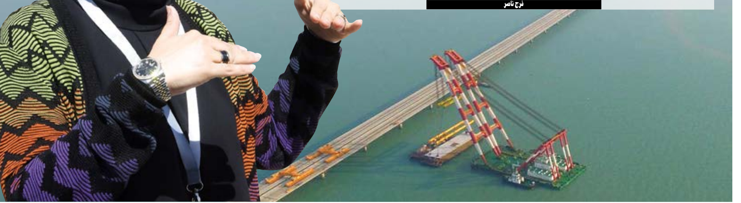
أعمال تركيب العوارض الصندوقية سابقة الصب باستخدام الرافعة المتحركة
