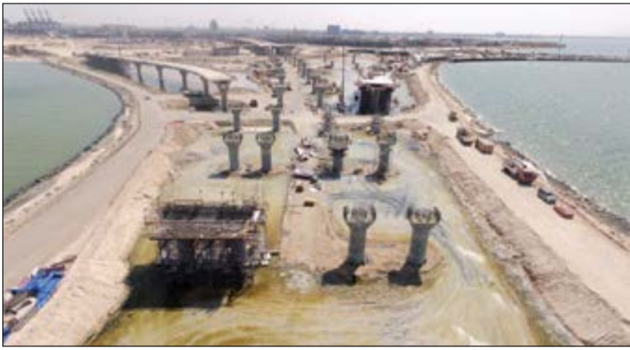
العوارض الصندوقية المصبوبة بالمواقع بجسر تقاطع الشويخ
