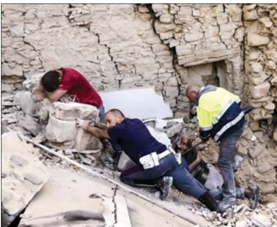
رجل يبكي فيما تتم معالجة آخر فوق انقاض المنازل المدمرة في امارتشي بإيطاليا (أ.ب)
