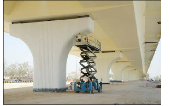
جانب من أعمال تطوير طريق جمال عبدالناصر
